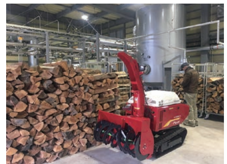
西目屋村の薪ボイラー視察
