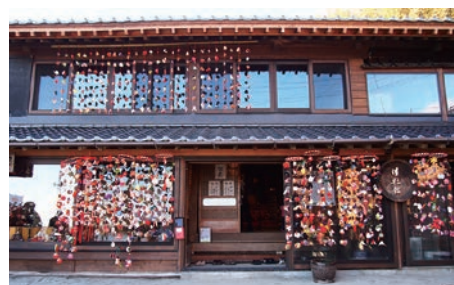
築200年を超える古民家を修復・再生した「清航館」
