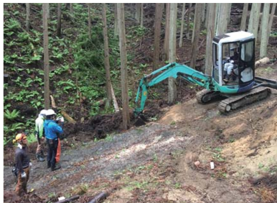
作業道敷設研修プログラム
