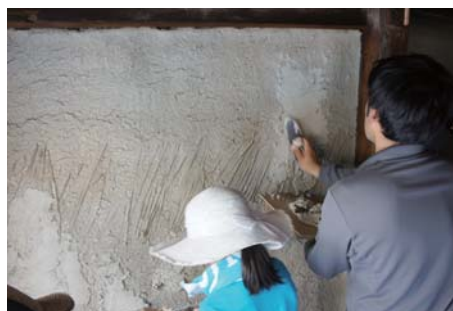
住民参加型でカマド小屋を建設(イメージ)
