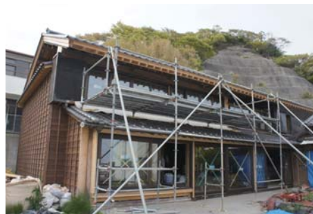
屋根・窓・壁板が取り付けられた古民家「清航館」
